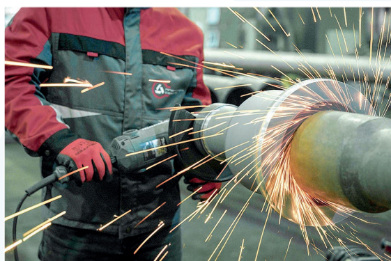
Процесс перешлифовки торца ниппеля
